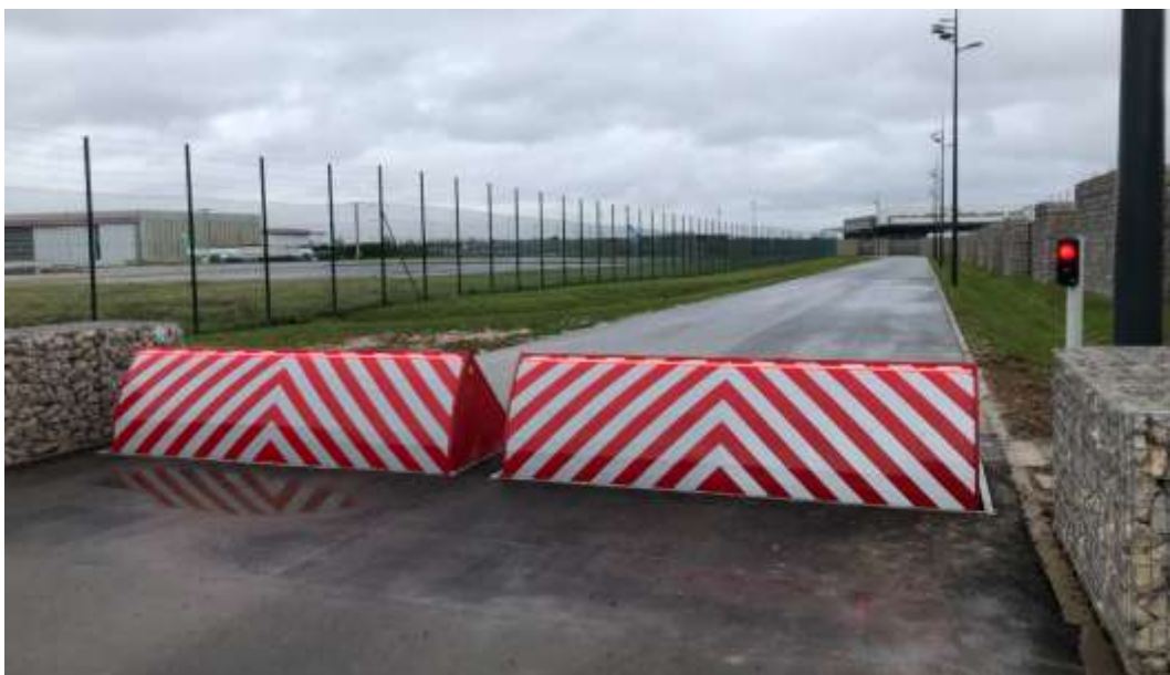
Barreras de cuña de profundidad
